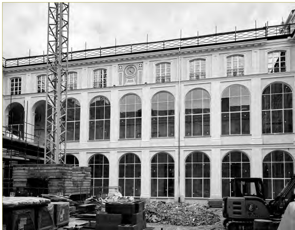
Il cantiere a Palazzo Santa Croce
