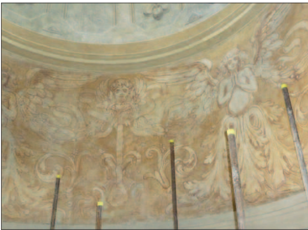
Fig. 3. Cappella, interno, tamburo, durante il restauro
