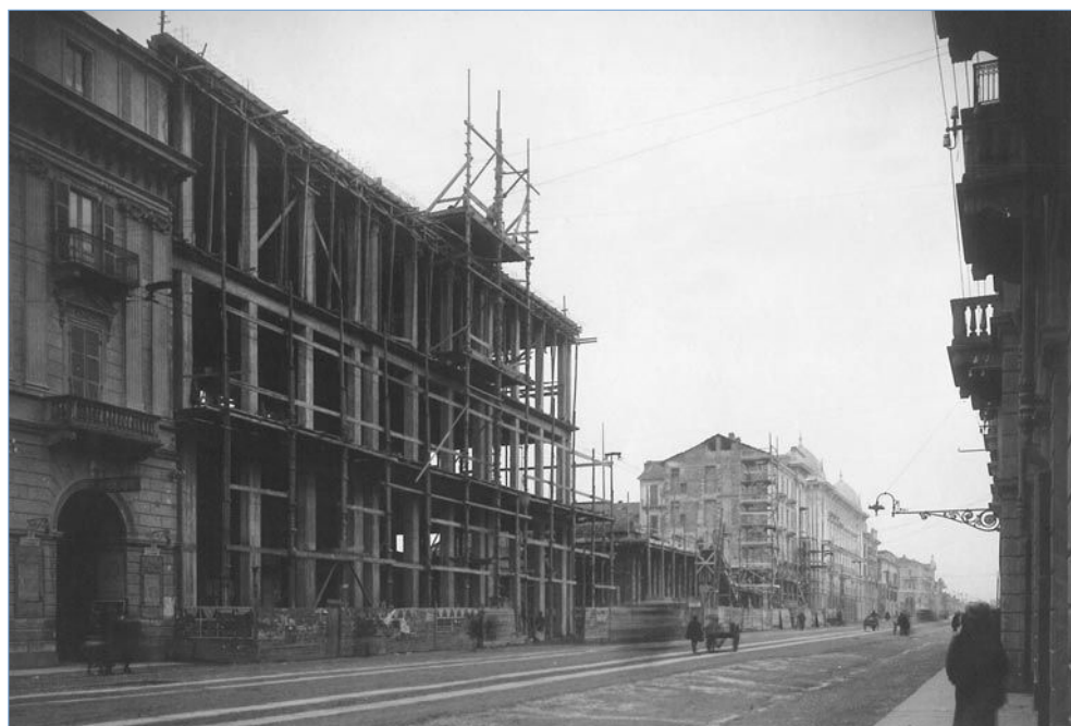
Palazzo della Banca d'Italia in costruzione, 1928 circa
