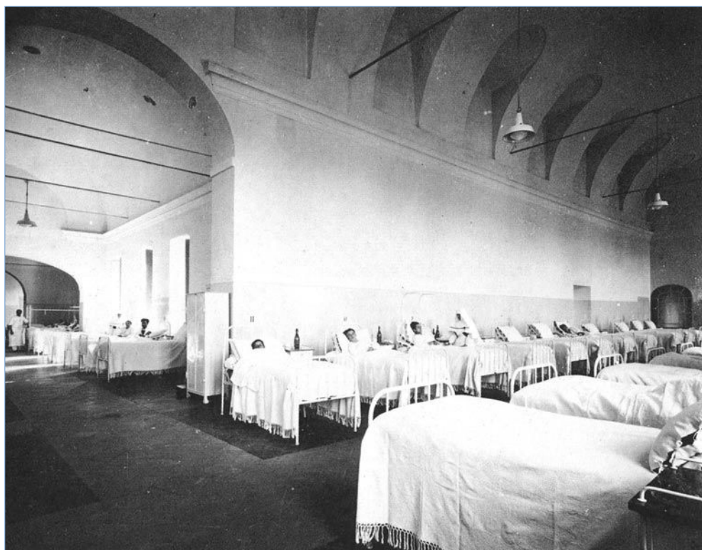
Corsia di degenza dell'ospedale in una foto dell'inizio del Novecento. Sono visibili sulla sinistra le aperture ottocentesche ad arco ribassato nelle murature portanti tra l'infermeria degli incurabili e i locali contigui
