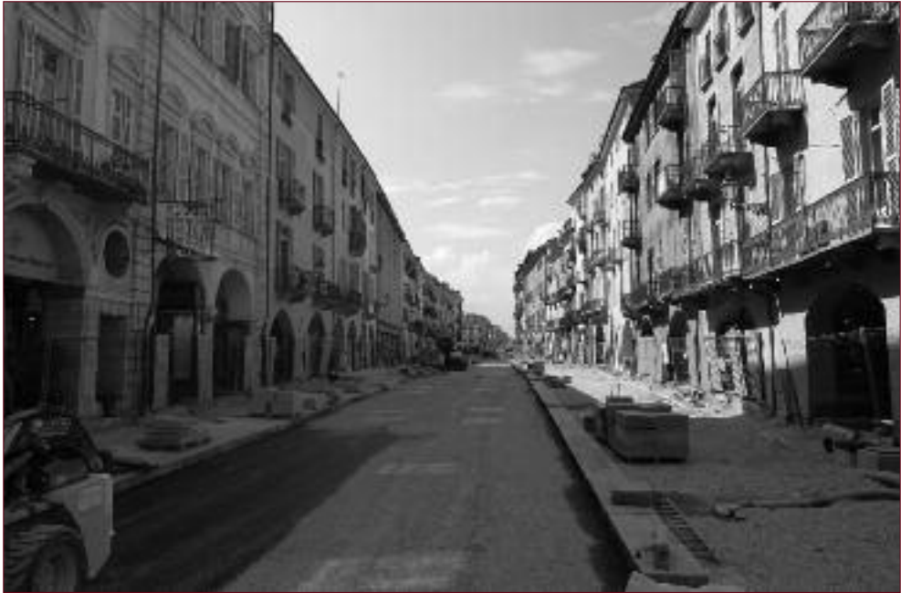
Cantiere in via Roma
