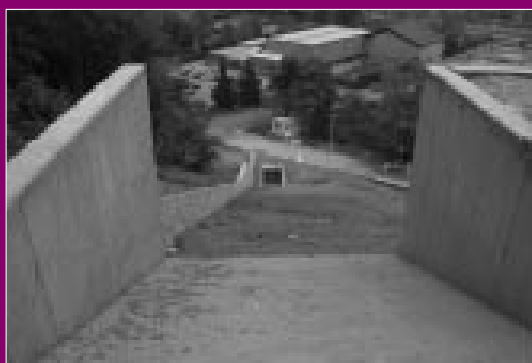
I lavori di costruzione dell'ascensore inclinato
