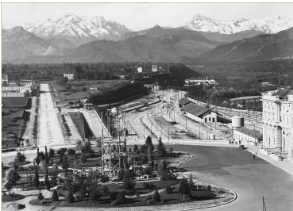
Il faro della stazione nuova in costruzione.
